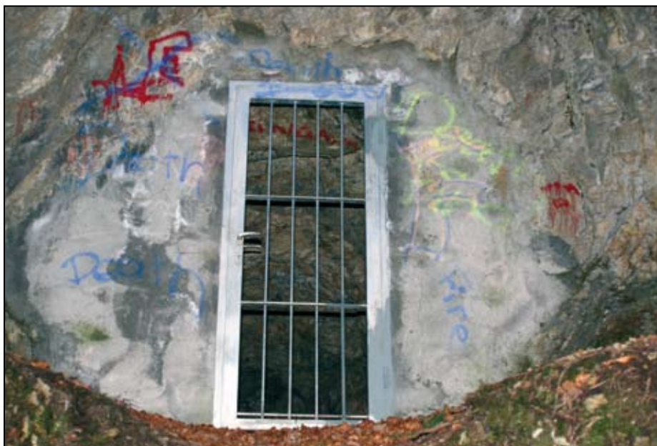
Repariertes Eingangstor. FOTO: KLAUS KRAINER
